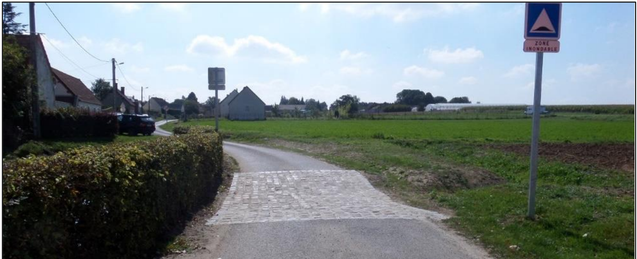
Figure 10 Exemple d'aménagement d'un passage à gué
