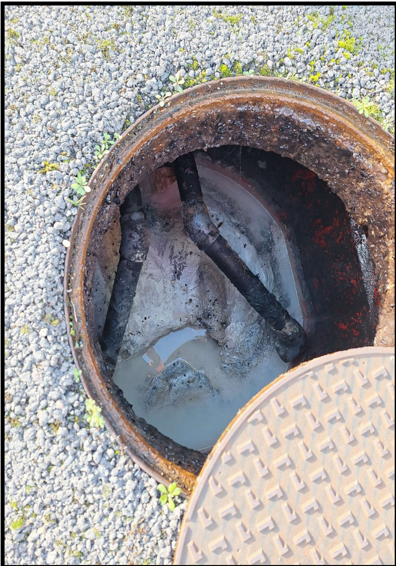
Préleveur et Canal Venturi ainsi qu'une Fosse de décantation avant rejet dans réseau
