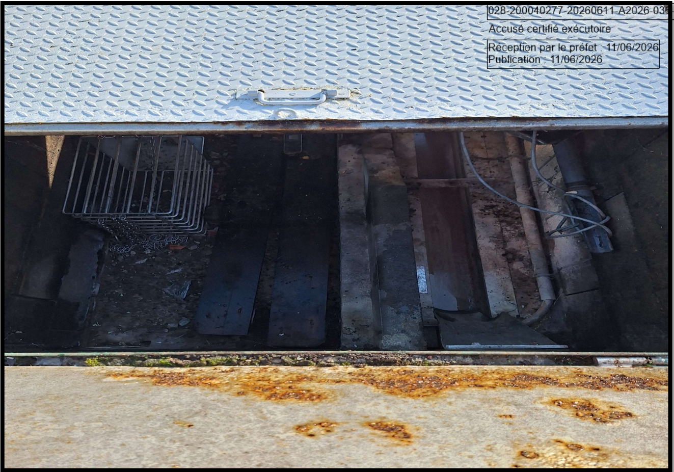
Préleveur et Canal Venturi ainsi qu'une Fosse de décantation avant rejet dans réseau
