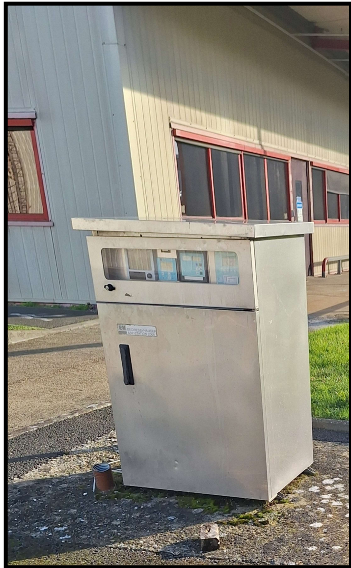
Préleveur et Canal Venturi ainsi qu'une Fosse de décantation avant rejet dans réseau
